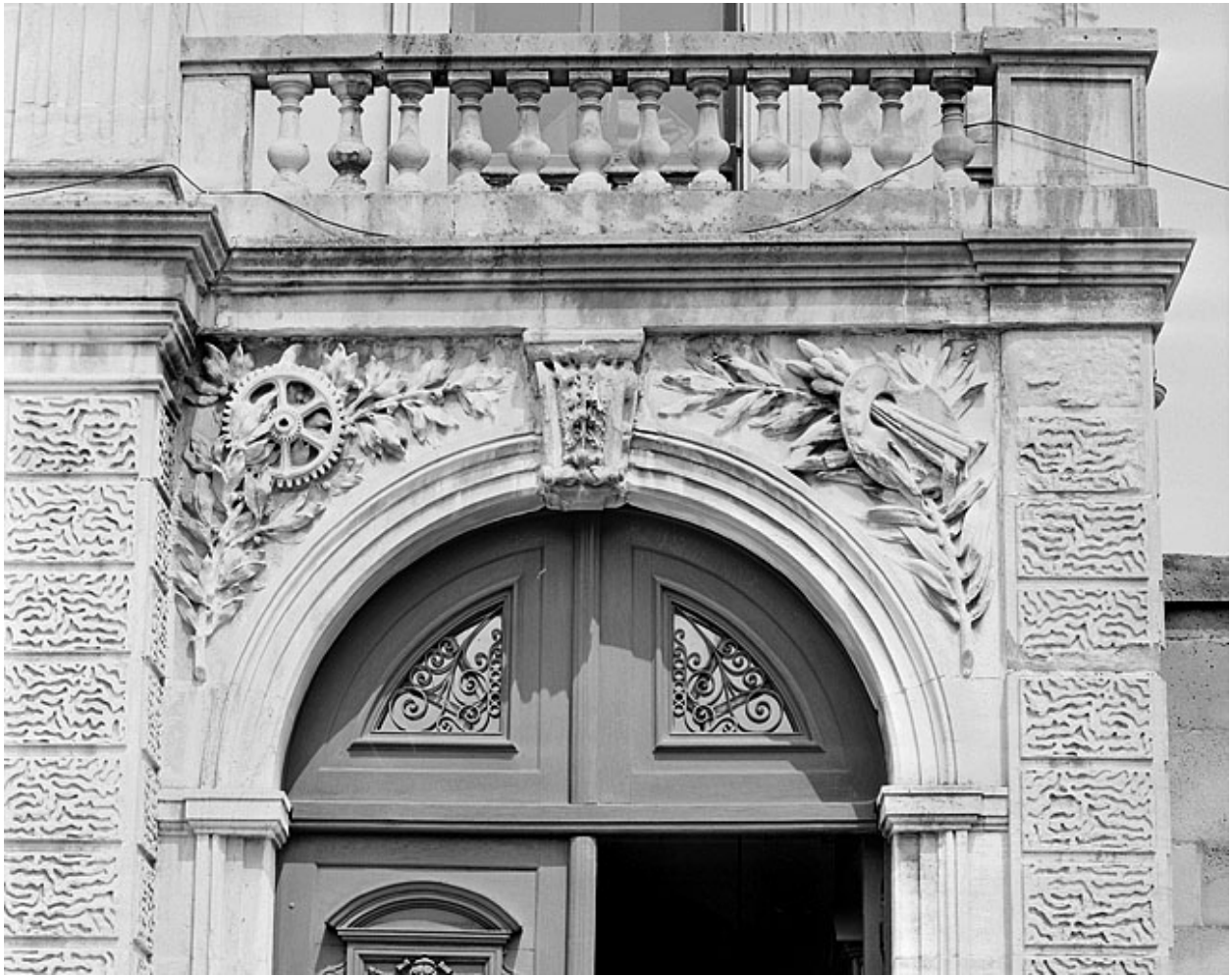
Banque. Façade principale, détail de la porte bâtarde.
