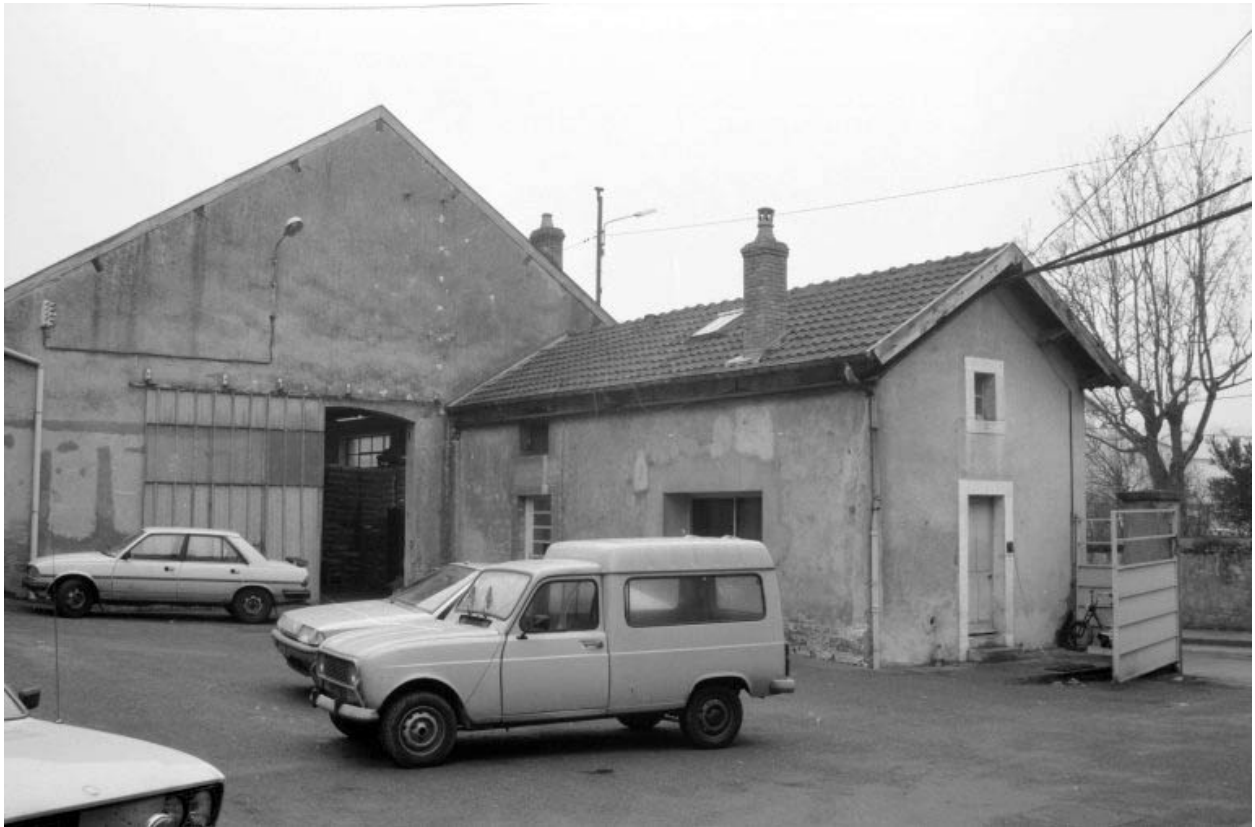
Entrée, cantine et entrepôt (8) vus de l'est.
