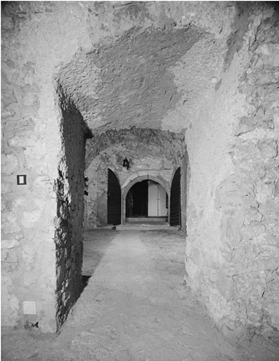
Enfilade de portes côté nord, prise de la salle est.
