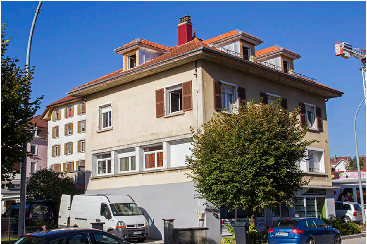
Façades antérieure et latérale gauche.
