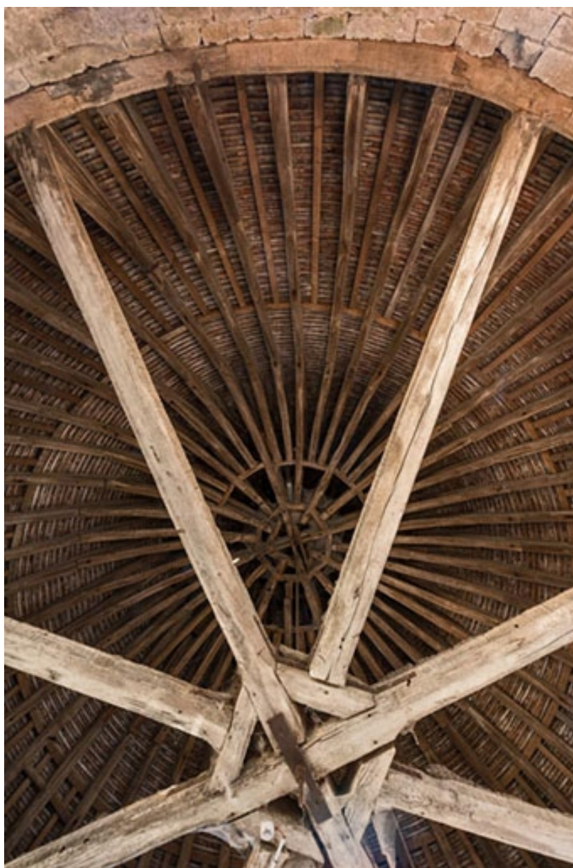
Tour Margot : charpente du 2e étage.
