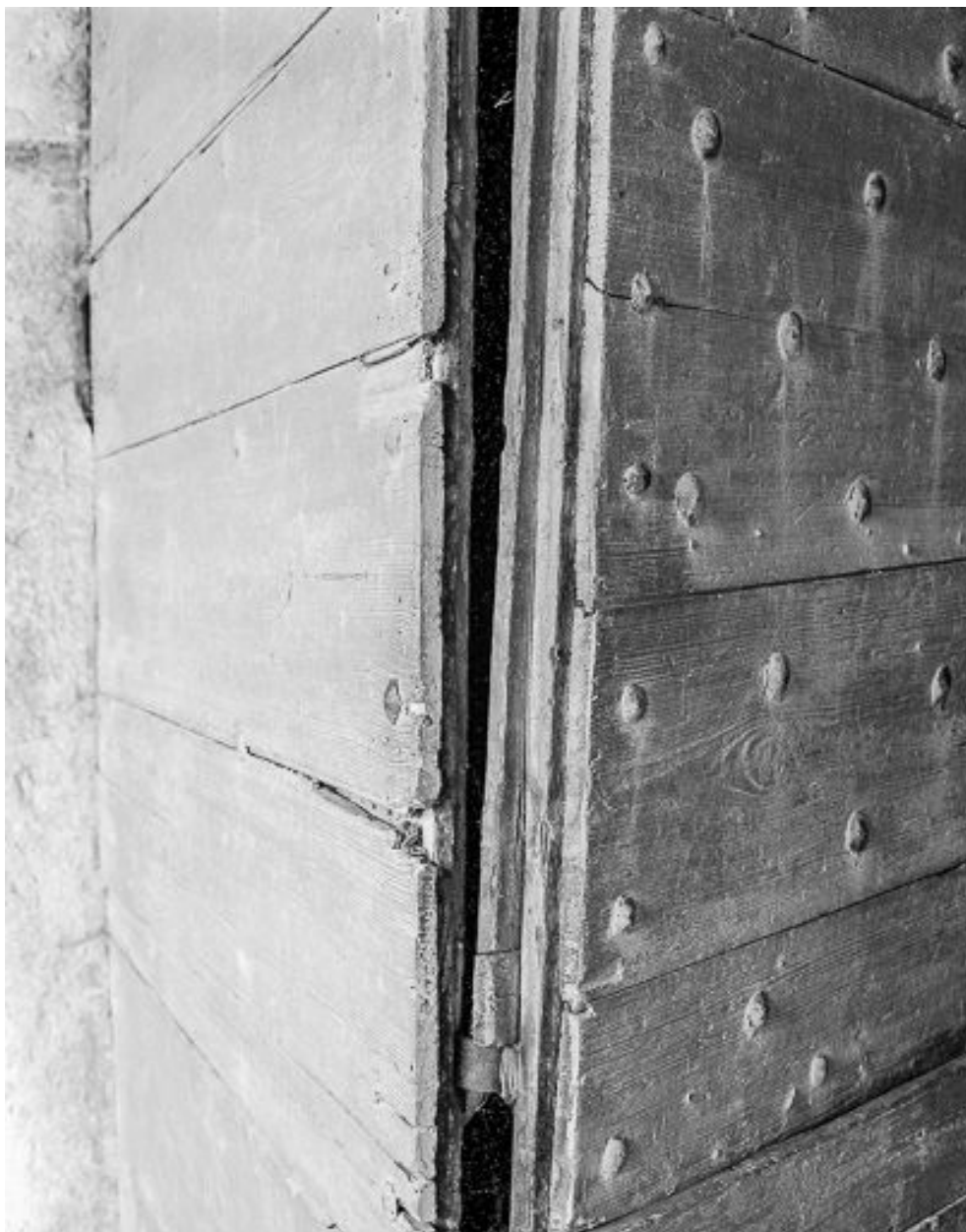
Porte piétonne de la porte de grange.
