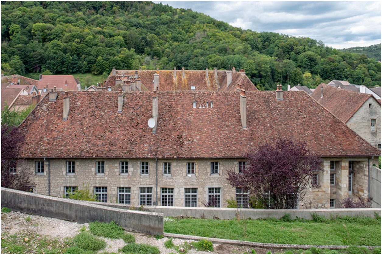
Bâtiment amont. Façade est.
