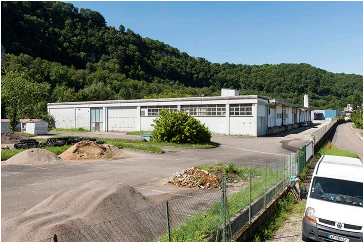
Etat en 2016. Usine C : extrémité orientale.
