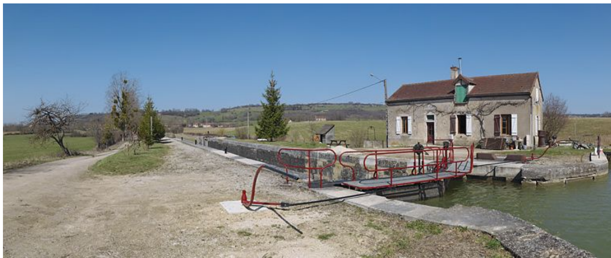
Le site d'écluse vu d'amont.
