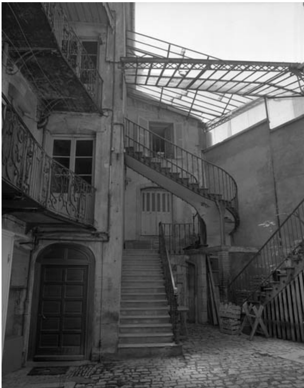
Détail de l'escalier de distribution extérieure.
