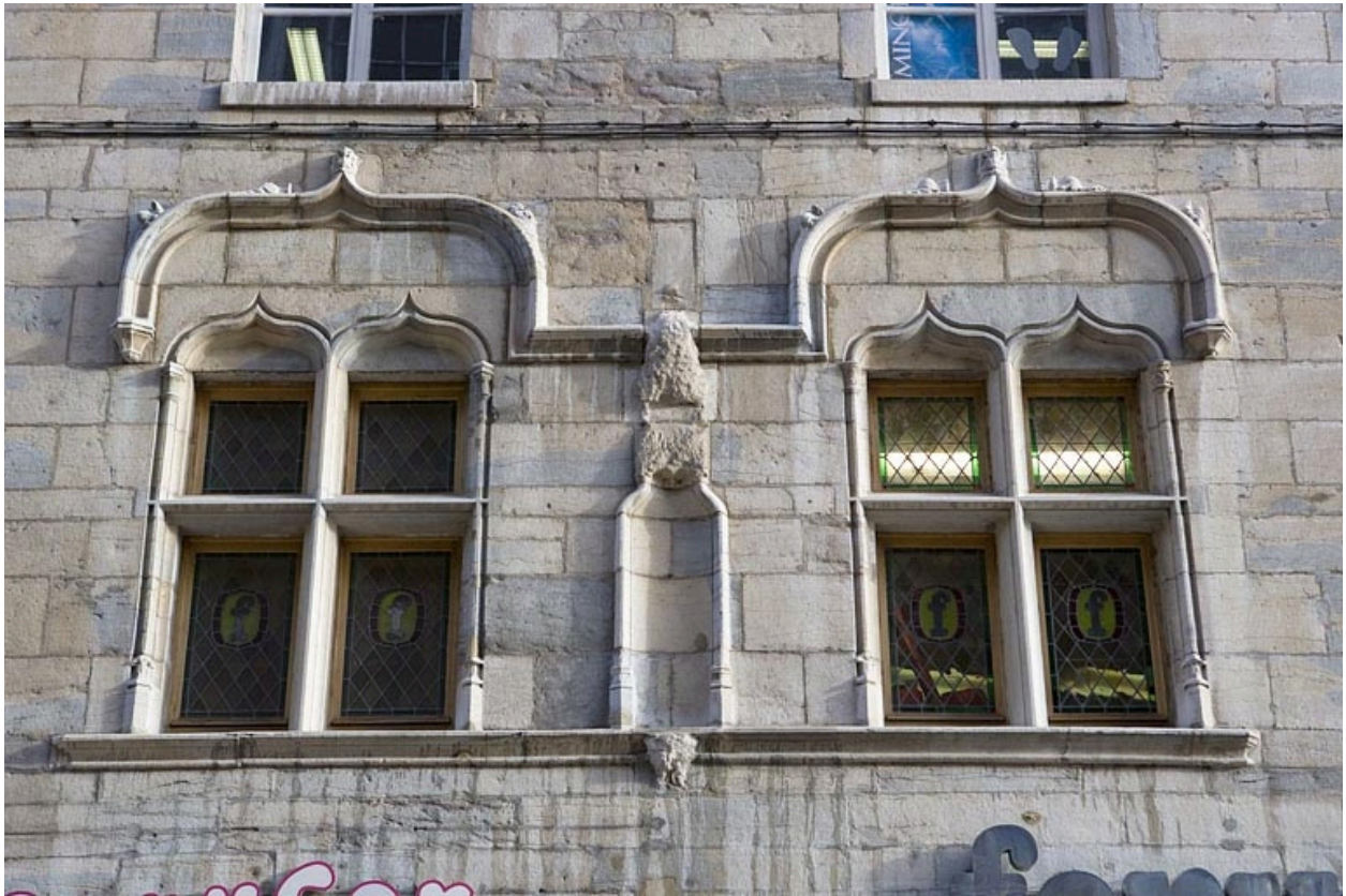
Façade antérieure du 15 Grande Rue : détail des fenêtres du premier étage.
