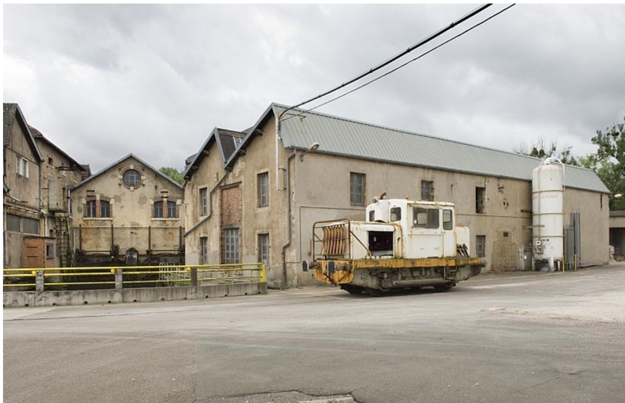
Bâtiment d'eau et atelier couvert de sheds.
