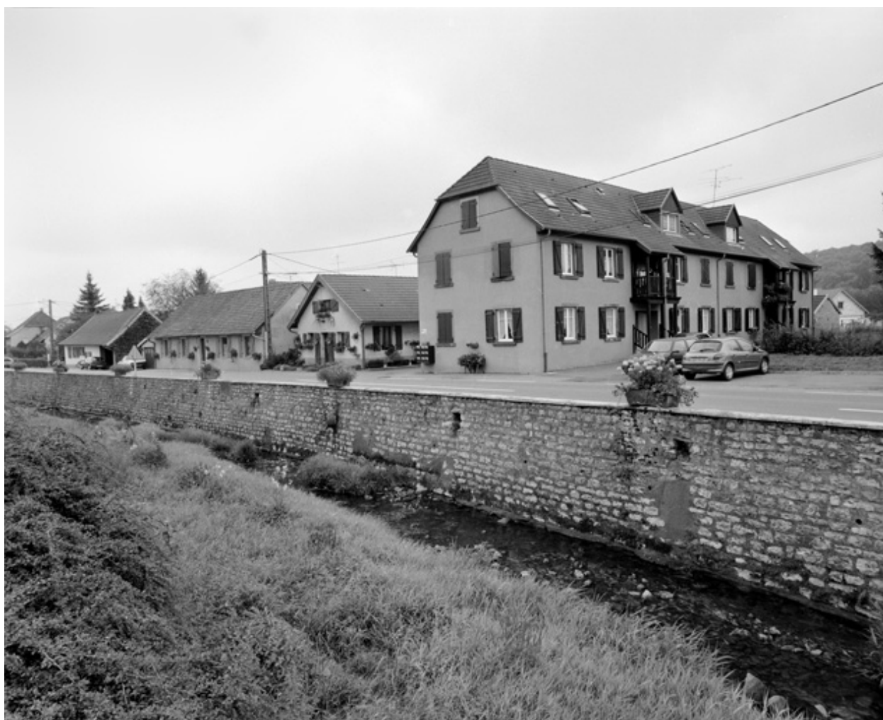
Vue d'ensemble des logements ouvriers.
