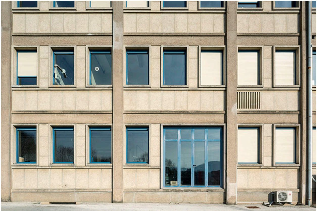
Façade postérieure, corps oriental : travées.
