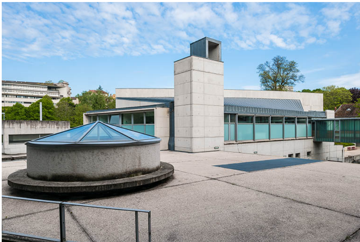
Angle sud-est du restaurant d'application.
