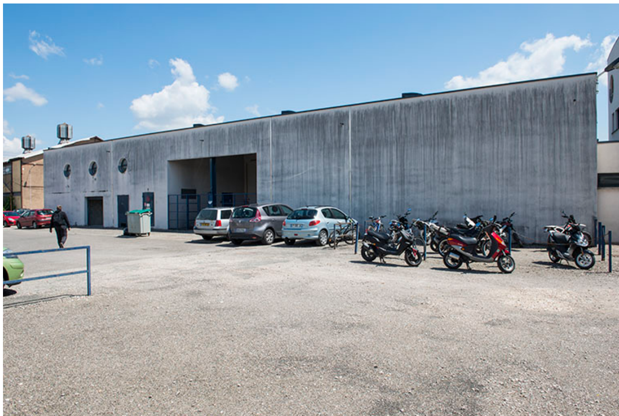
Façade ouest de l'atelier.
