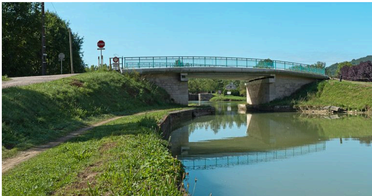
Vue du pont.
