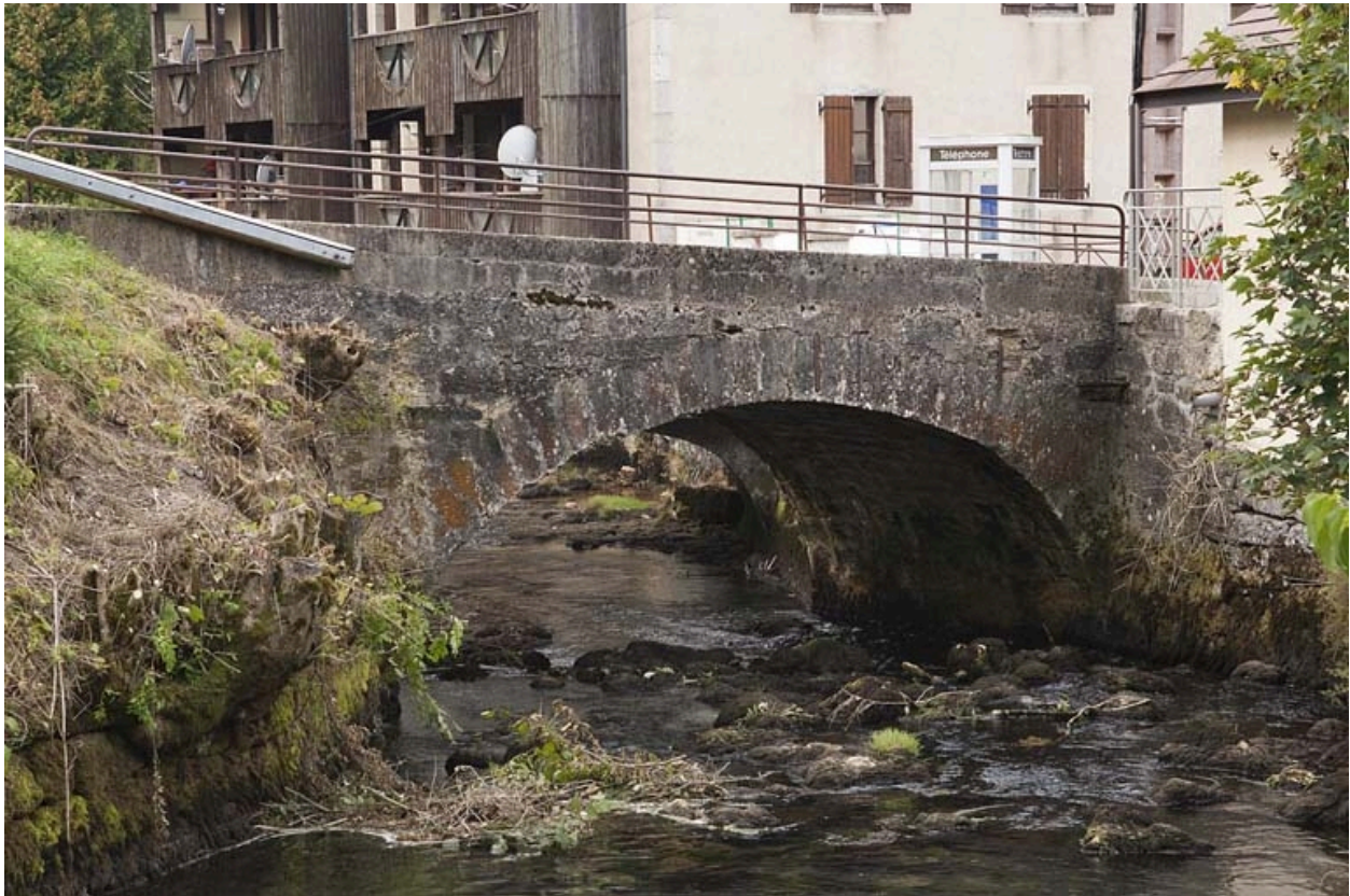
Pont sur la Jougne (n° 13), vu depuis l'amont.
