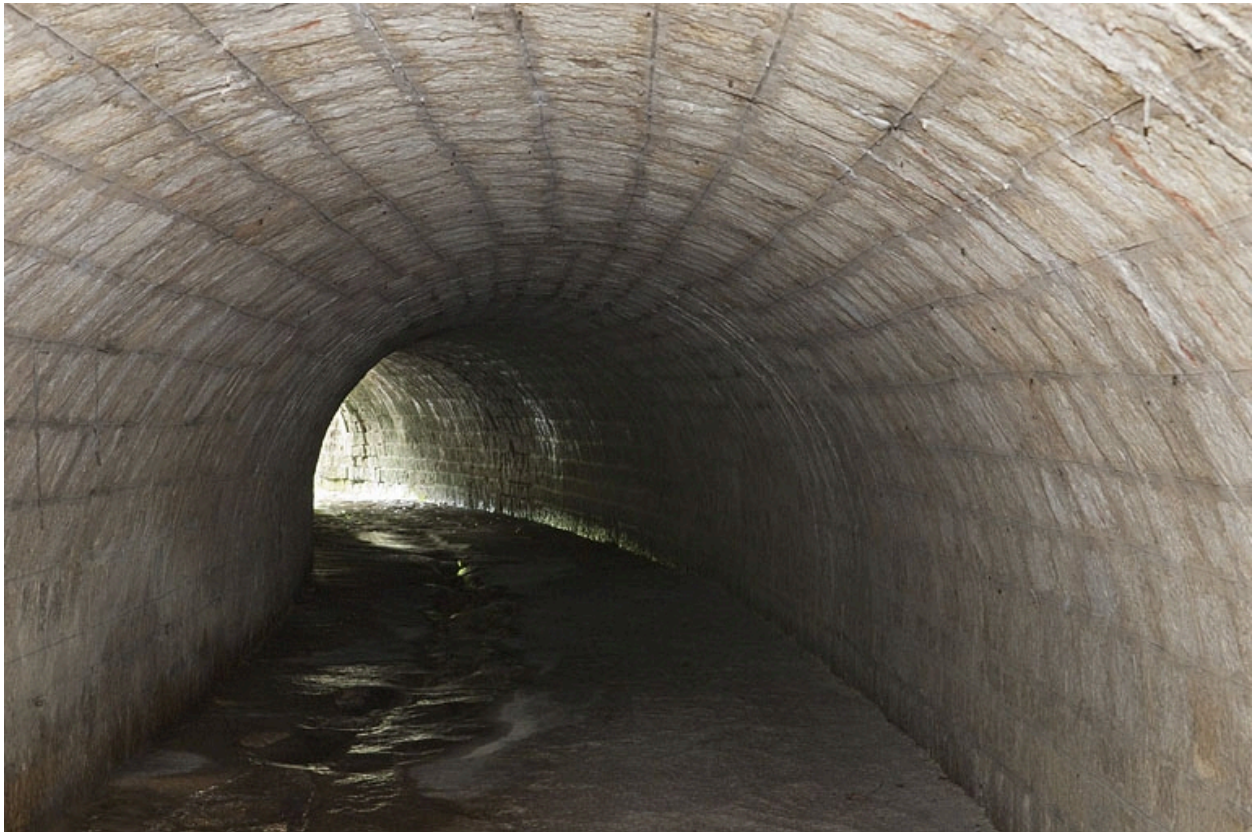
Intérieur du pont-aqueduc du Vaubillon (n° 6) en direction de la Ferrière.
