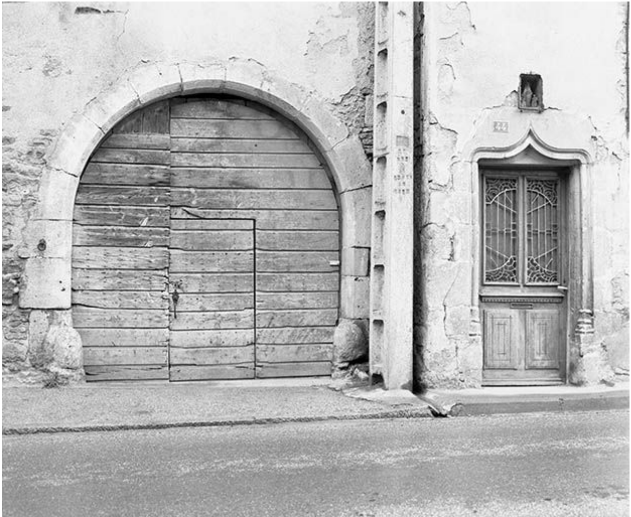
Maison (AK 36) 44 rue Edouard Bastide : porte cochère et porte piétonne.
