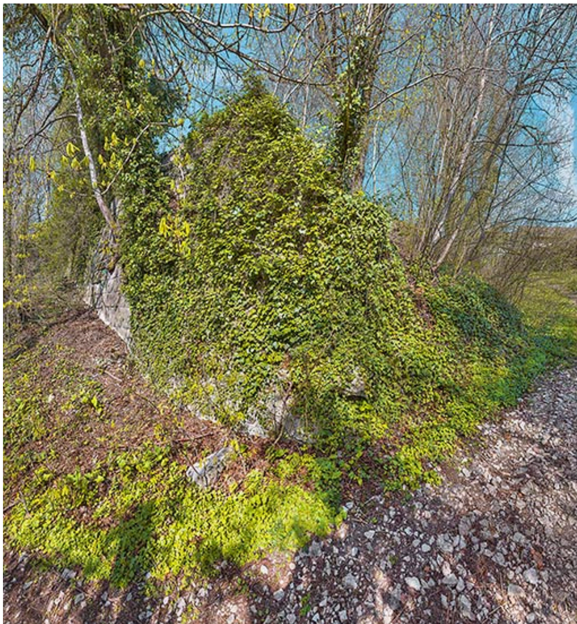
Tronçon de rempart ruiné.
