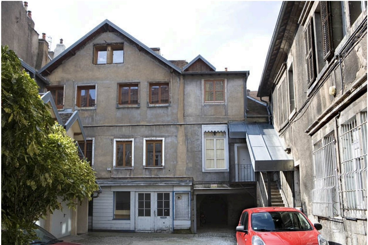
Vue d'ensemble des bâtiments en fond de cour.
