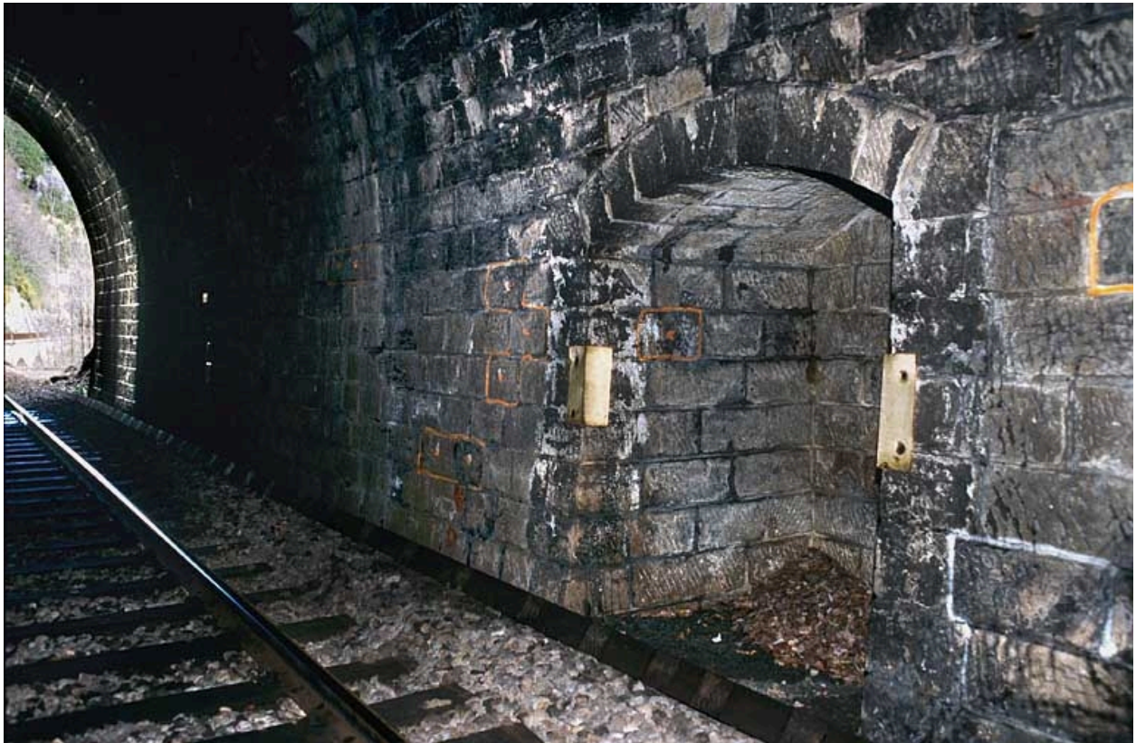
Tunnel du Champ de Bienne : refuge.
