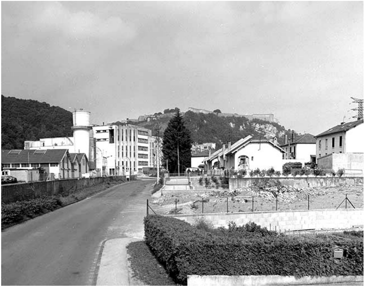
Chemin des Prés de Vaux : usine A et cité ouvrière.
