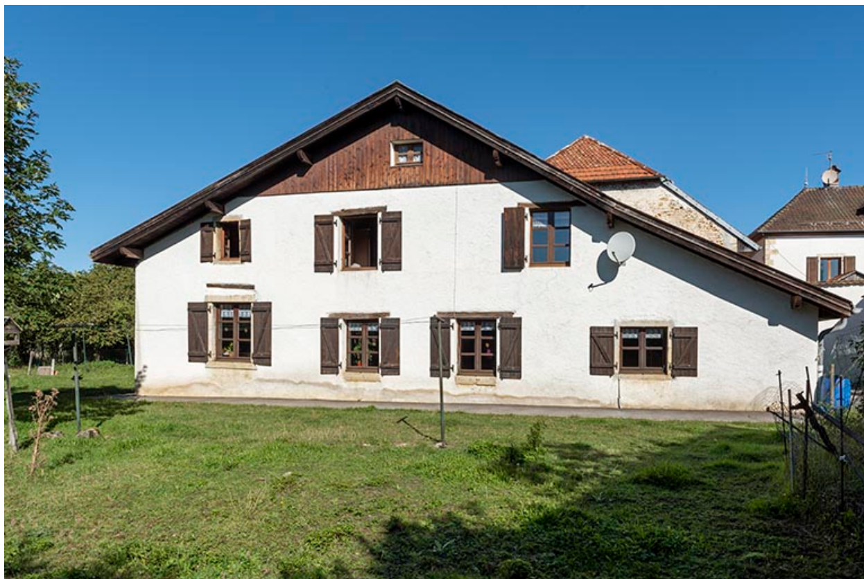
Maison au n° 47 : façade latérale gauche.
