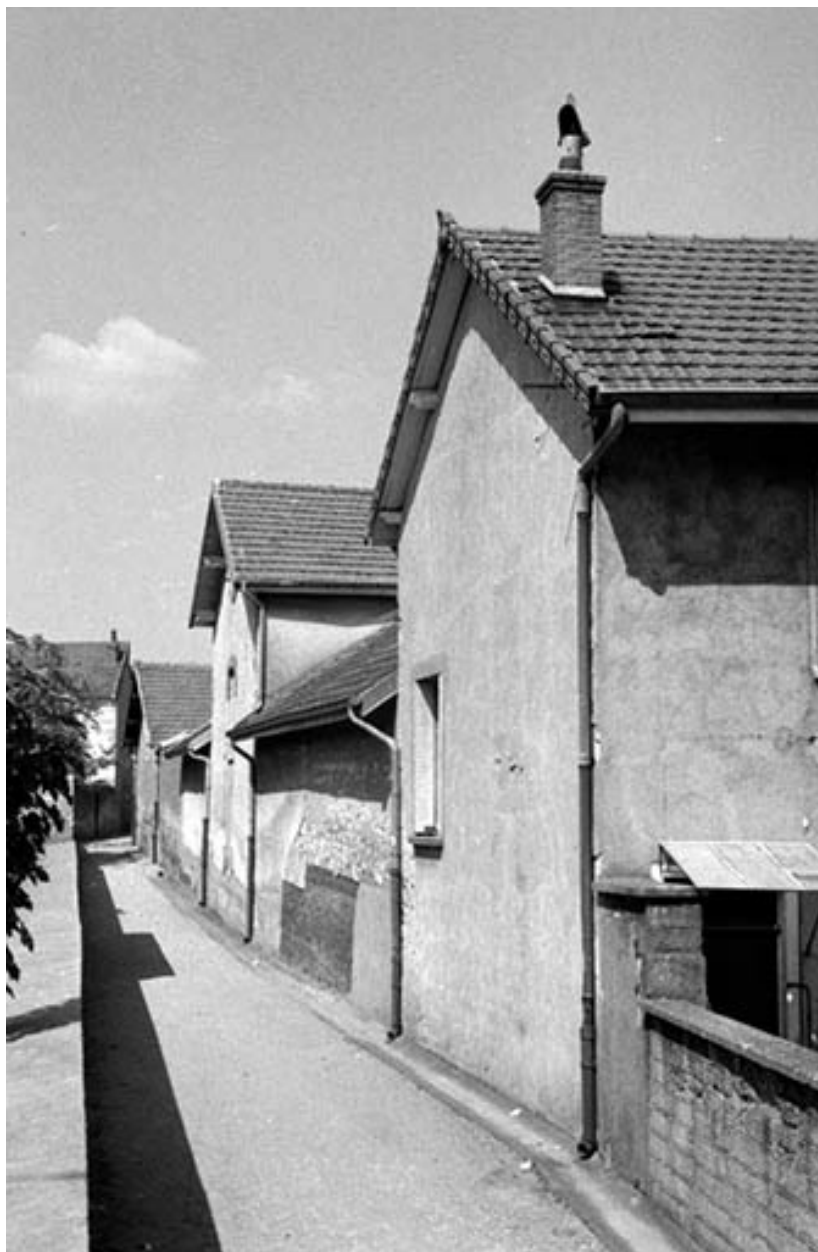
Façade postérieure des magasins industriels.
