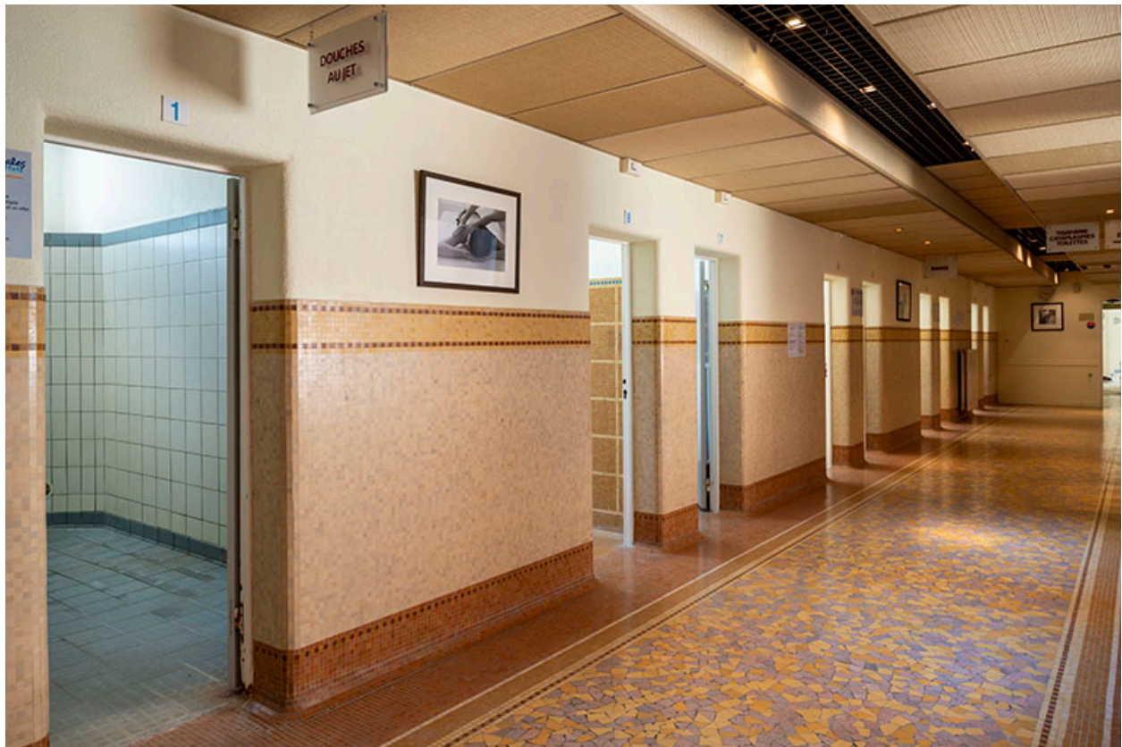
Bâtiment d'Hygie, couloir central du rez-de-chaussée, vue en direction du nord.
