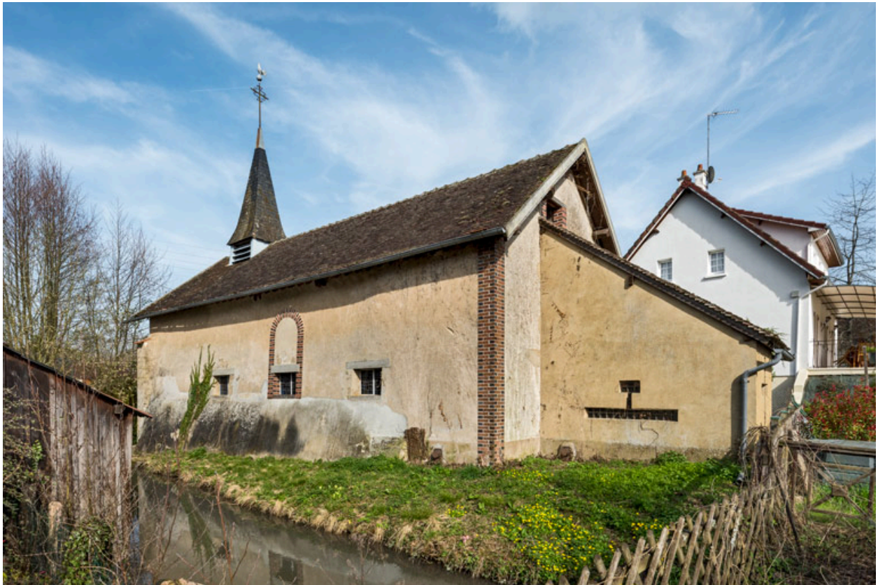
Vue de la façade nord.
