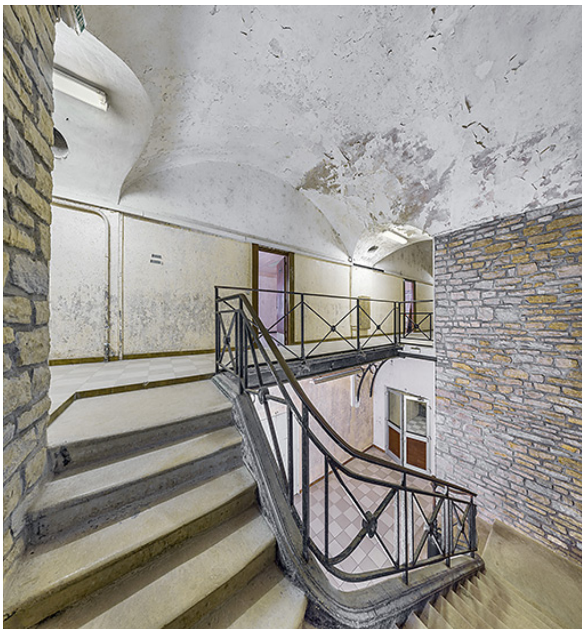
L'escalier entre le premier étage et le rez-de-chaussée.
