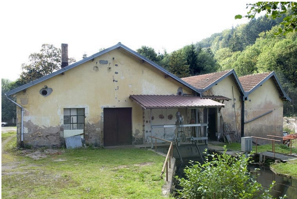
Pignon nord de l'atelier de fabrication.
