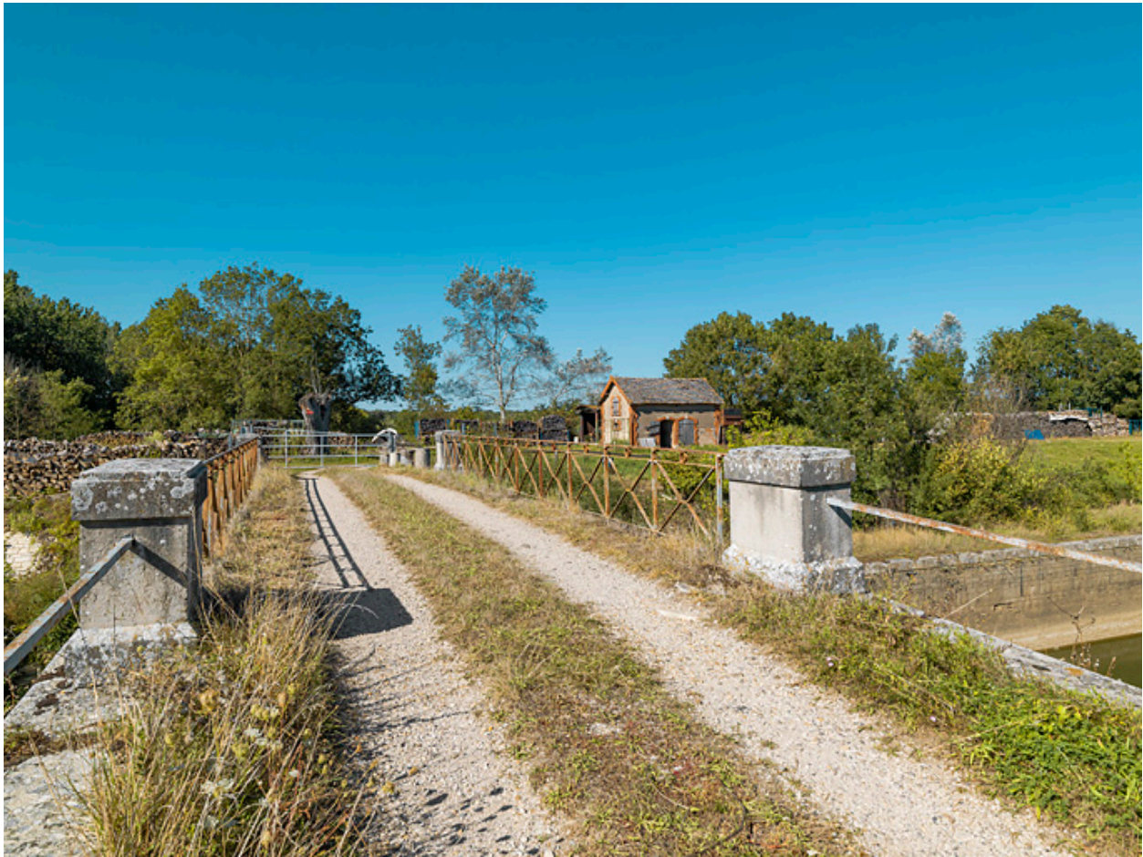
Vue d'ensemble du pont sur l'écluse.
