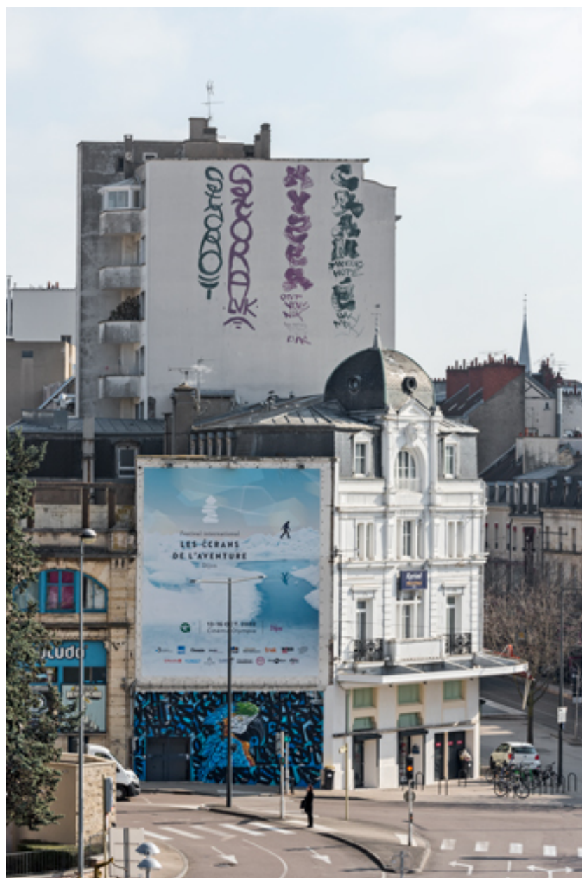
Vue d'ensemble, depuis l'ouest (cadrage vertical).
