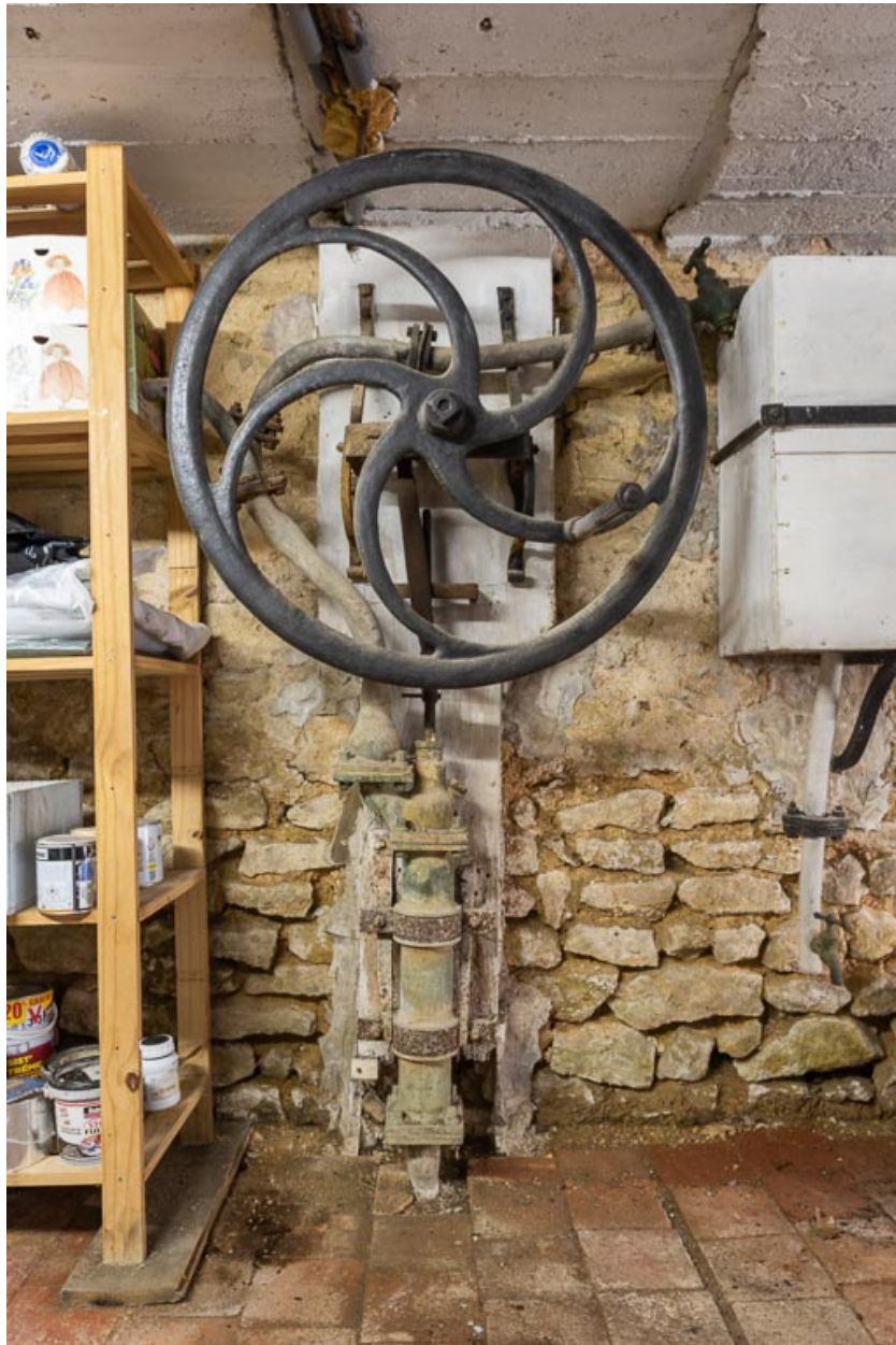
Pompe à manivelle de la cave.
