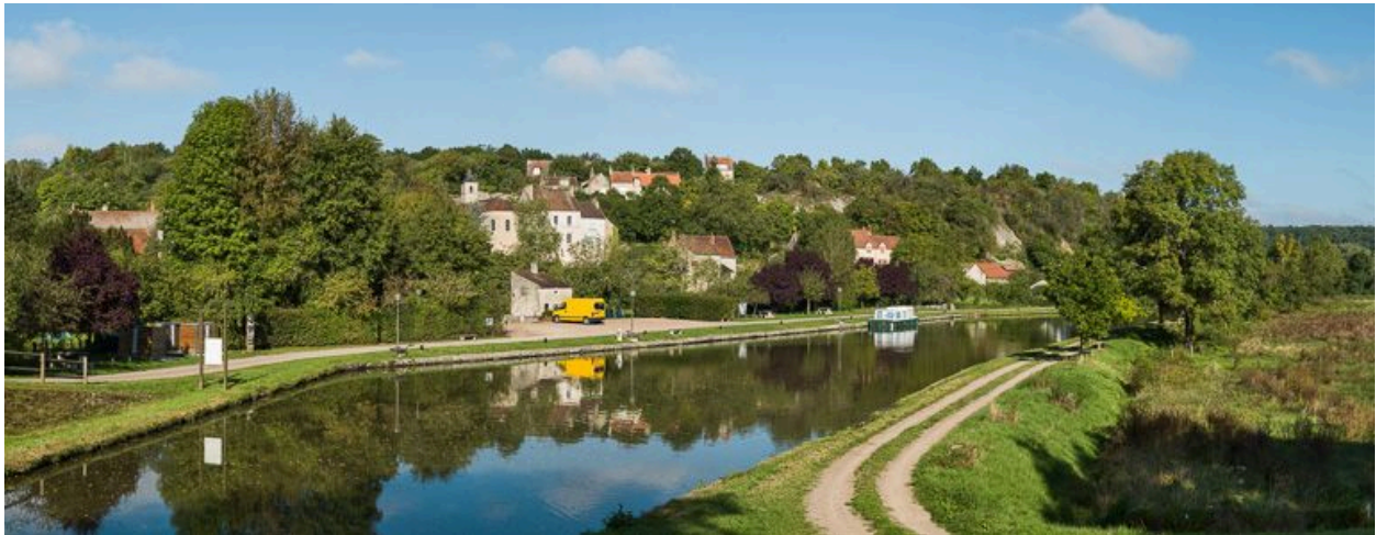
Vue d'ensemble du port de Chevroches pris d'amont.
