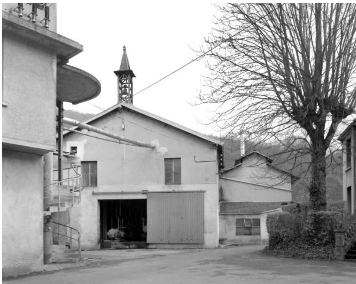
Atelier de fabrication et chaufferie.
