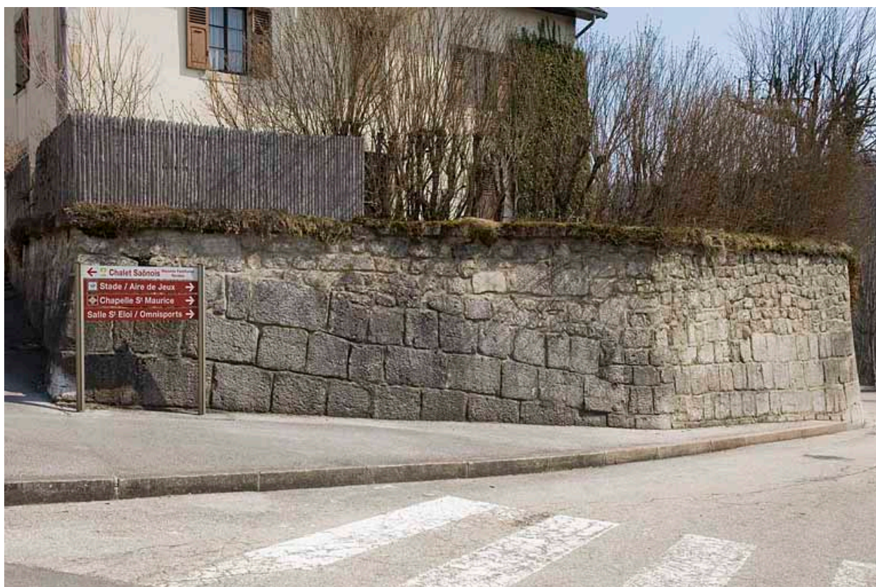
Enceinte au niveau de la maison Billet.
