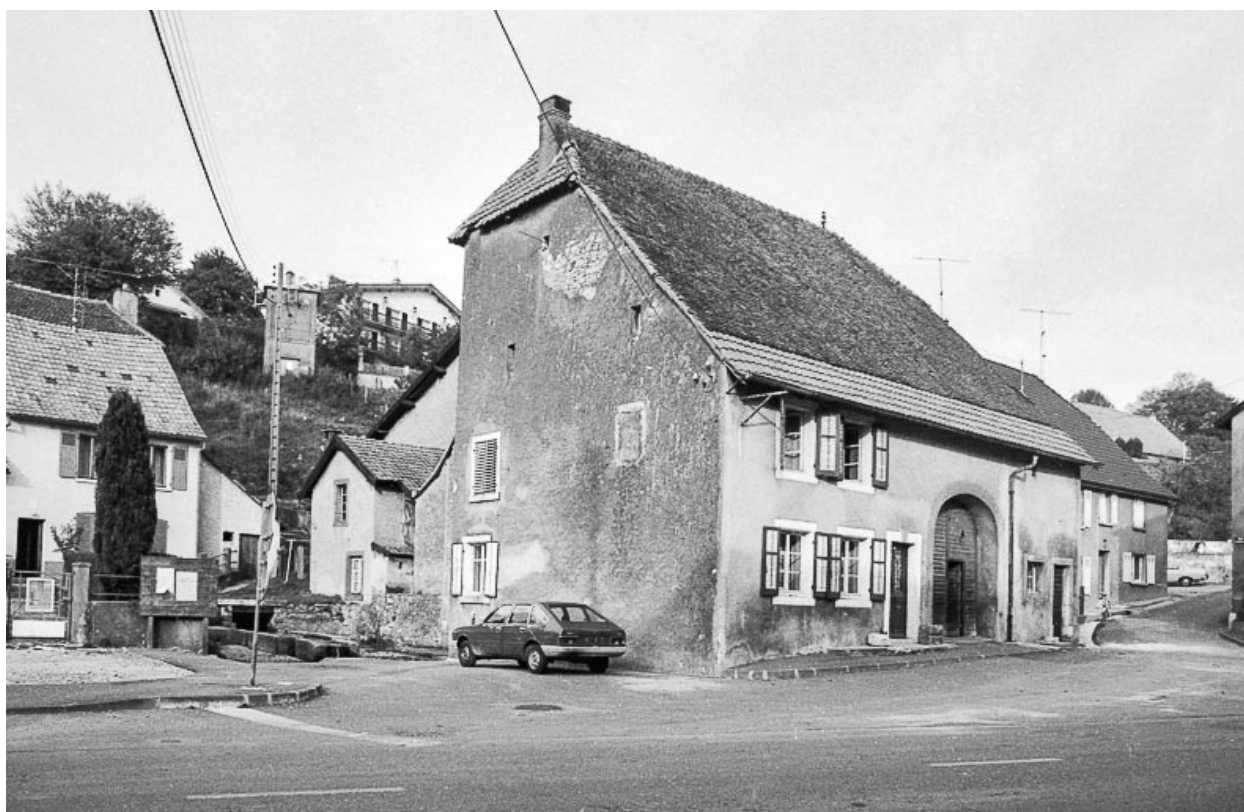
Arbouans : ferme située rue du Château d'Eau.
