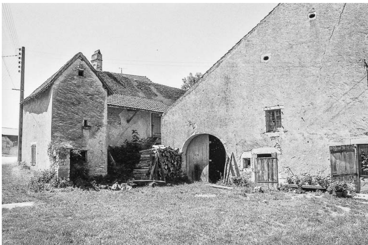
Vue de trois quarts gauche du bâtiment.
