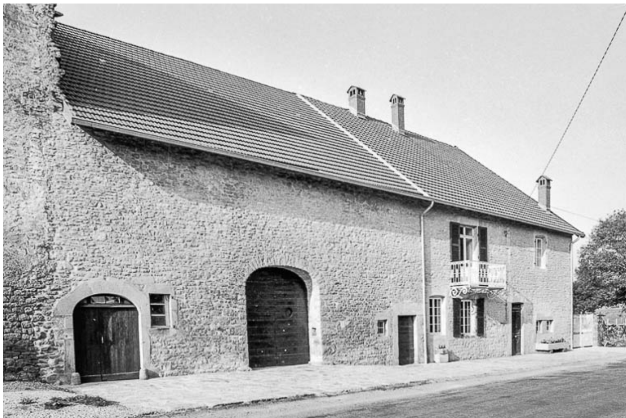
Ferme cadastrée A3 218 : façade antérieure.
