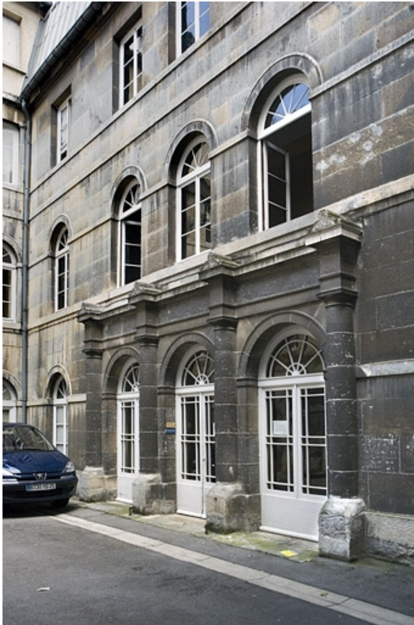
Aile droite sur cour : vue de l'entrée de l'escalier principal de trois quarts droit.
