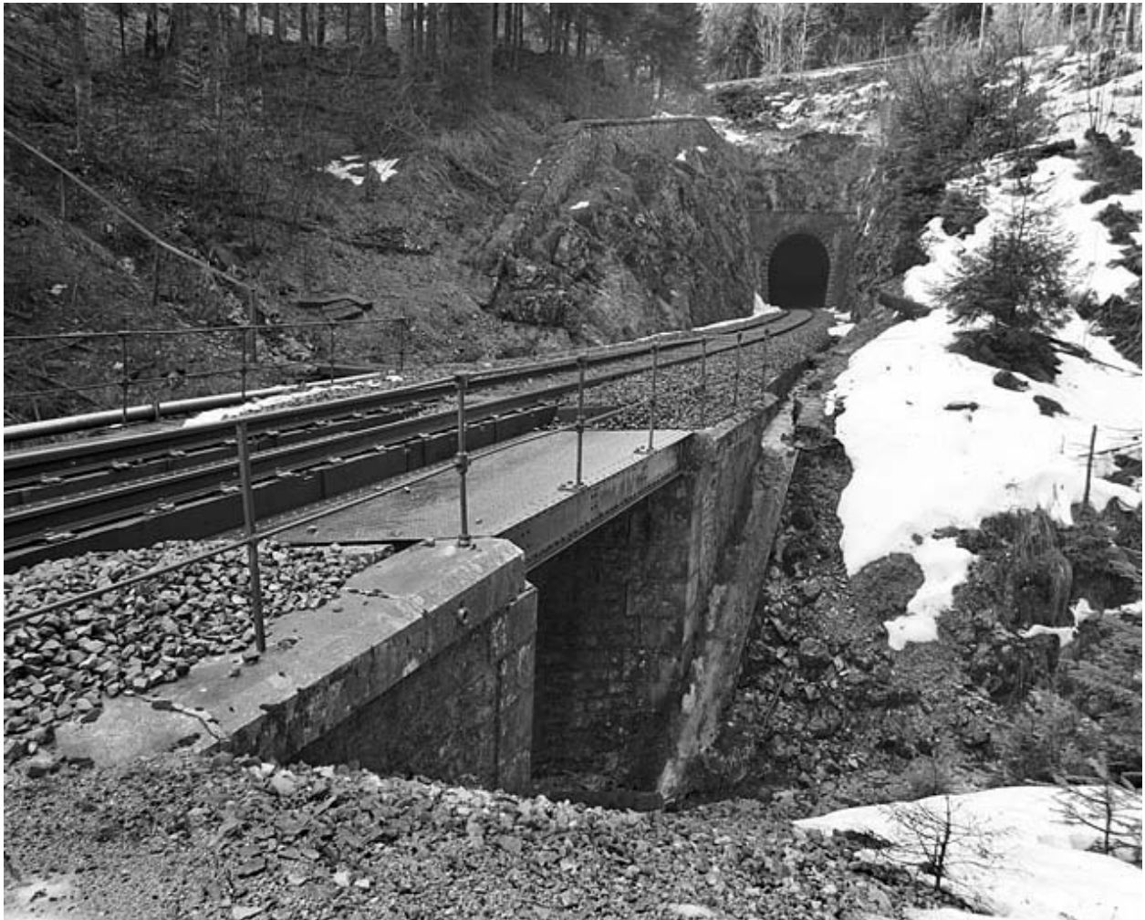
Pont et tunnel : vue d'ensemble du côté Andelot-en-Montagne.
