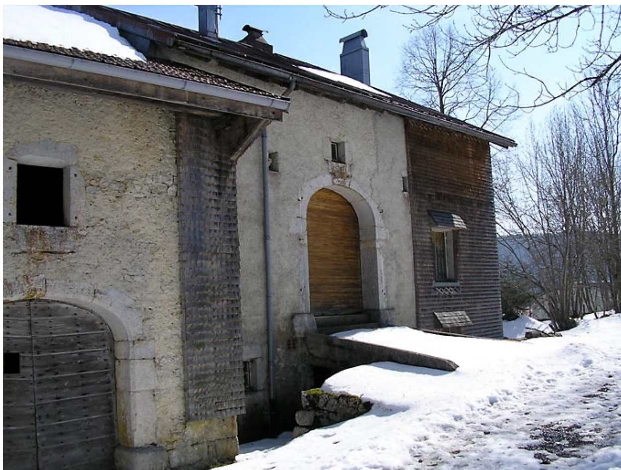
Ferme située au lieu-dit Les Jeannez.
