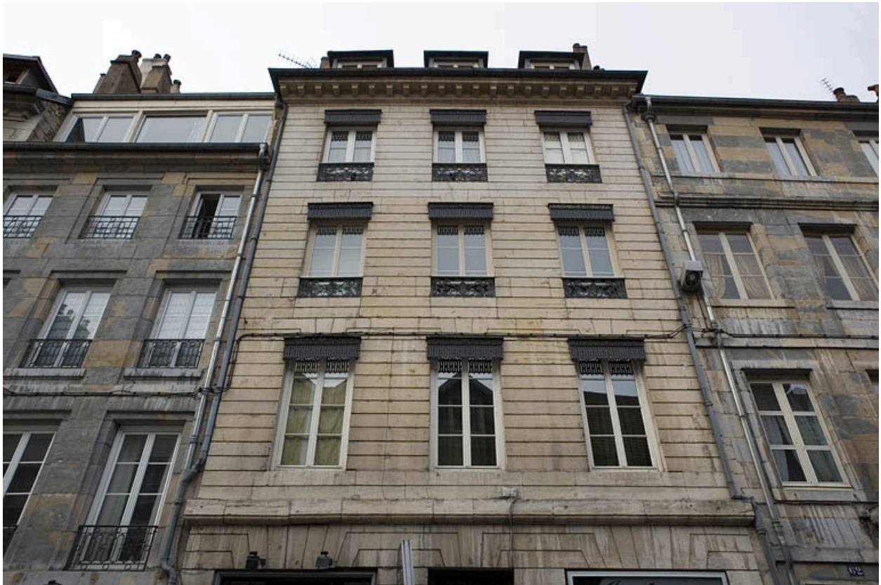
Détail de la façade sur rue au-dessus du rez-de-chaussée.
