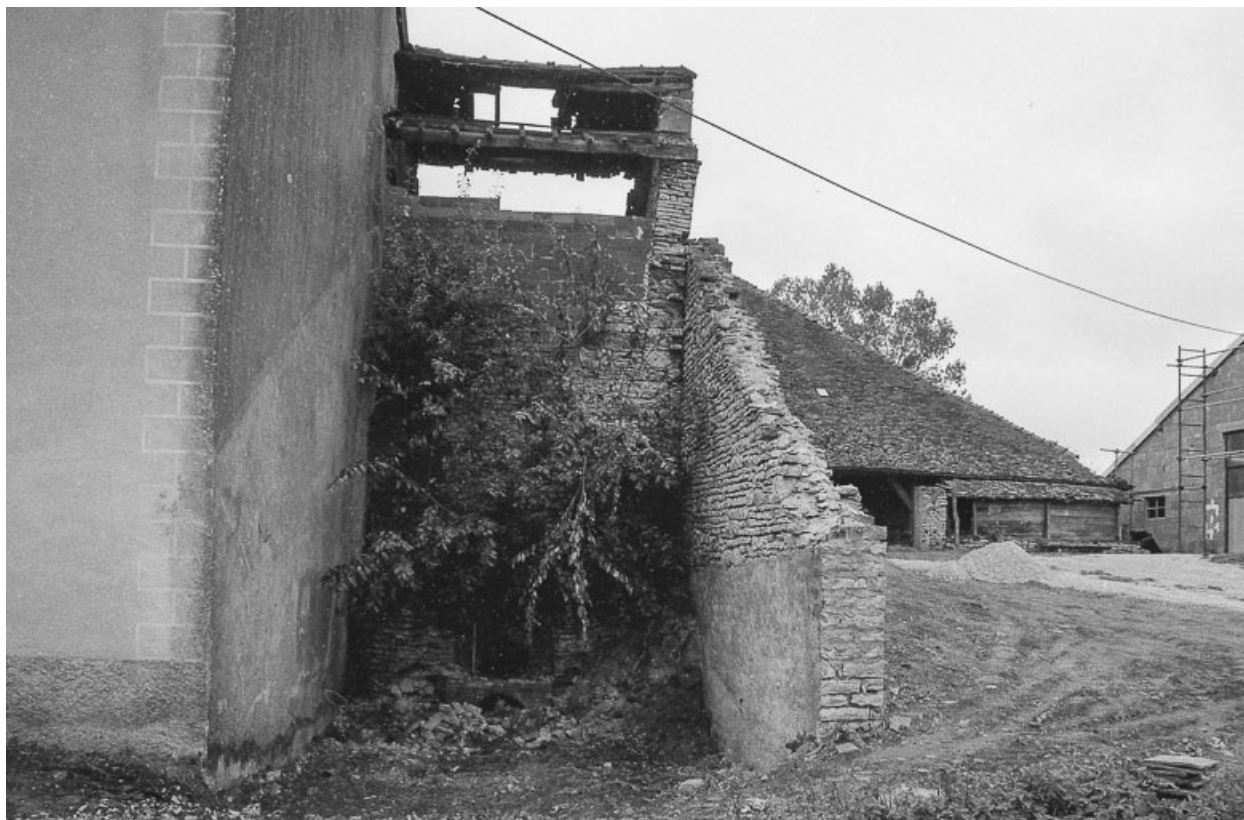
Le four, façade postérieure.
