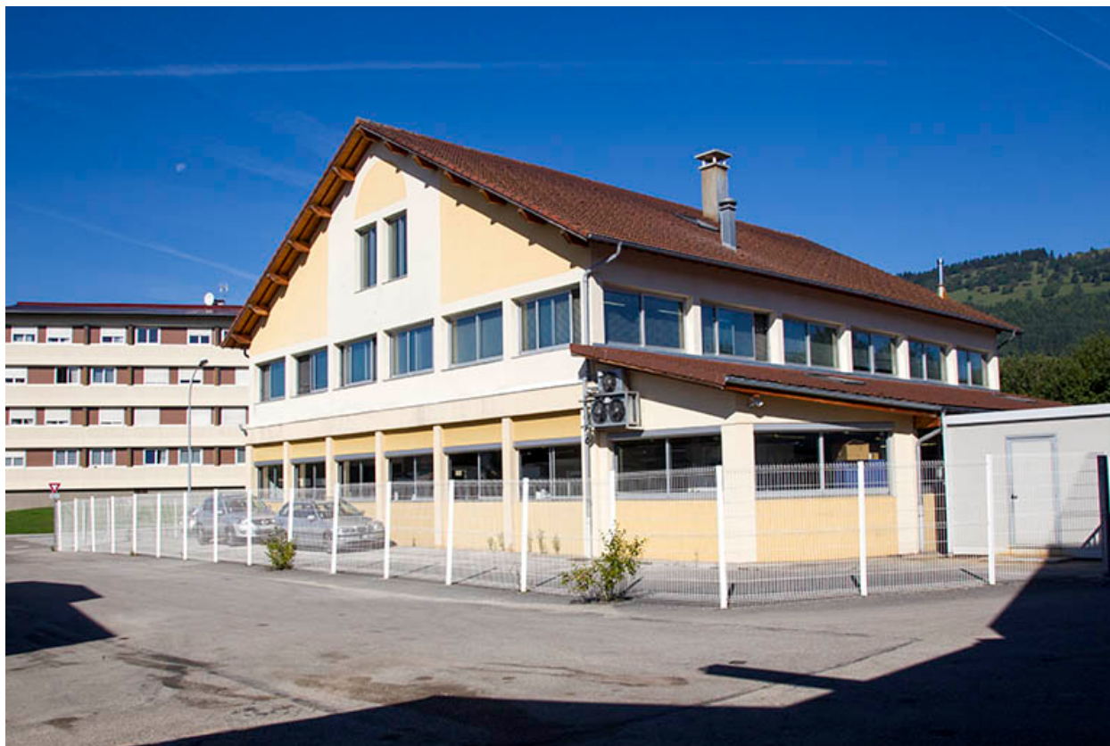
Façades postérieure et latérale droite.
