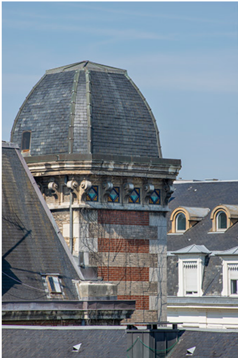
Toiture en dôme de la tour de l'ancienne entrée.
