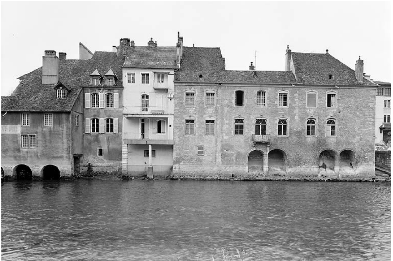
Façades postérieures des édifices situés rue de la Froidière, vue générale.
