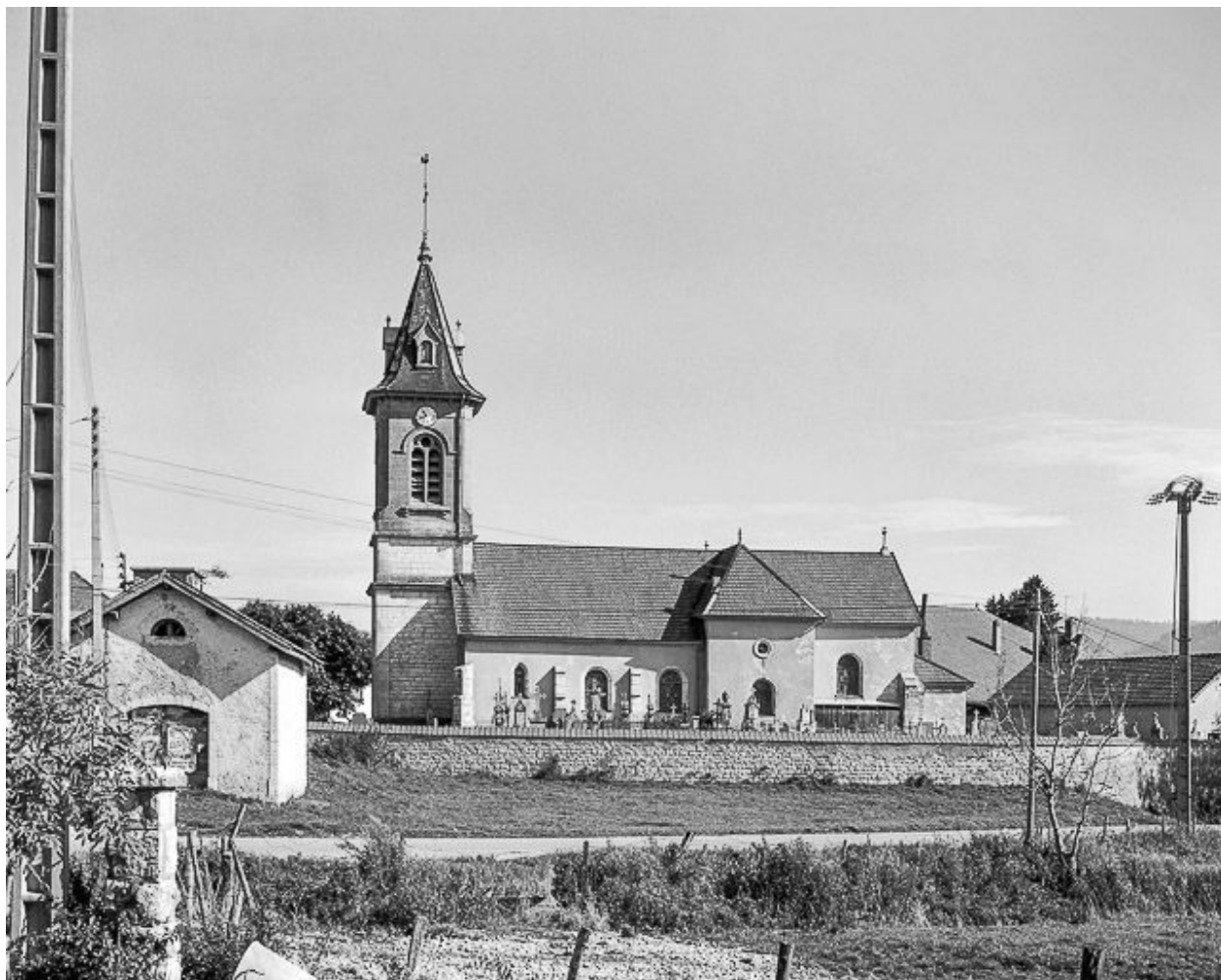
Façade latérale droite.
