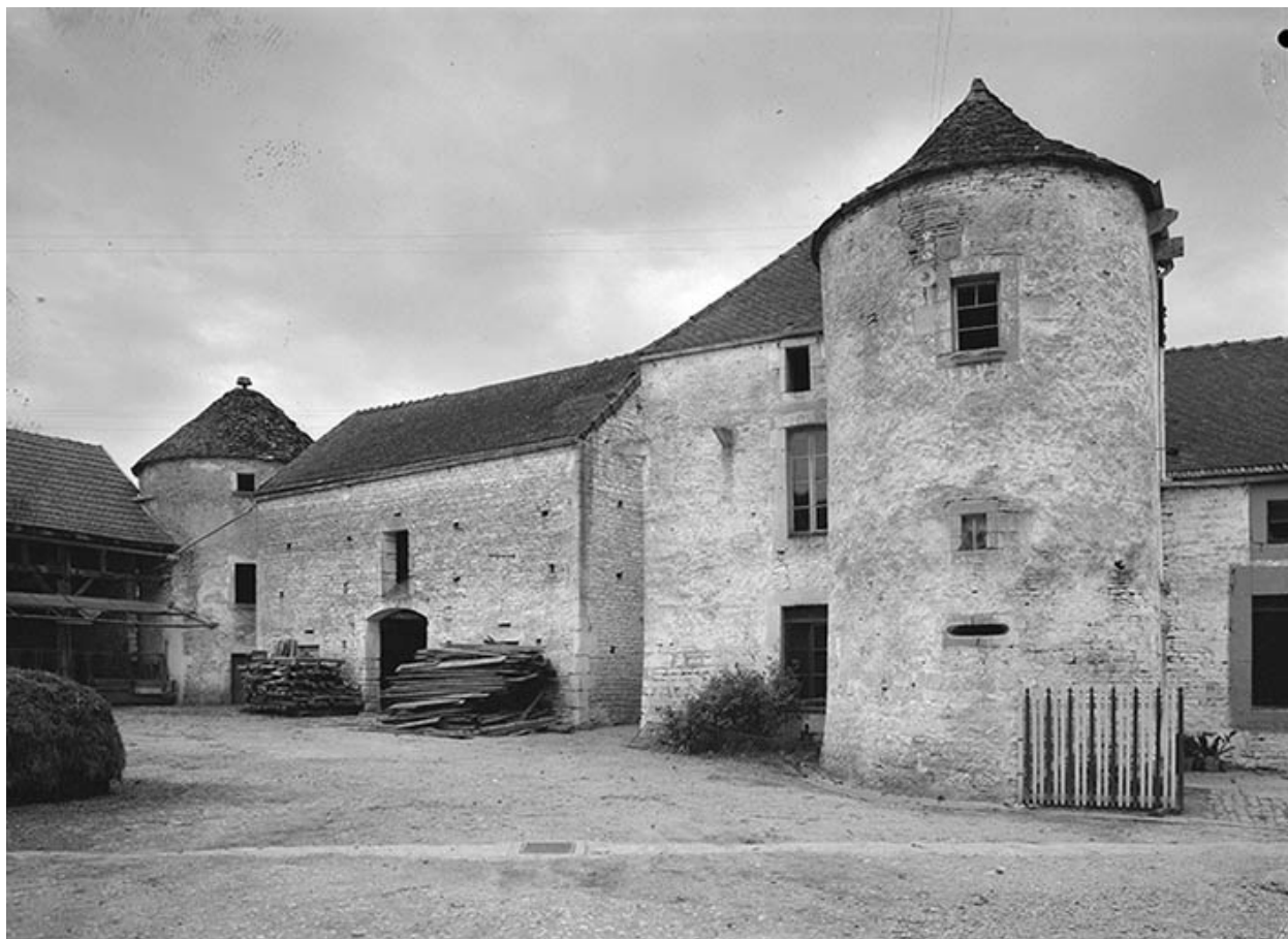
Dépendances et tour. Façades sur cour.
