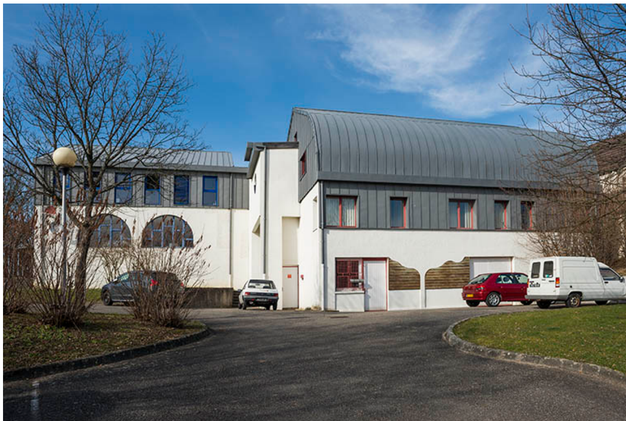
Façades sud de l'administration.
